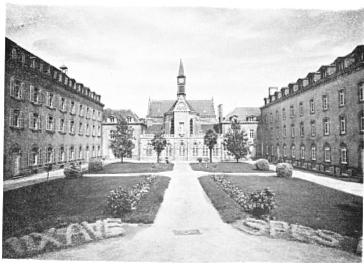
MAISON-MÈRE — LA COUR INTÉRIEURE
