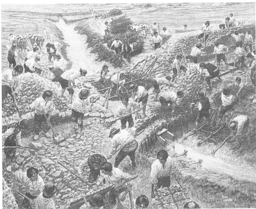
Construction d'une digue par des paysans acadiens dans les terres basses de Grand-Pré, en Nouvelle-Écosse. La canalisation de bois, appelée aboiteaux, laisse les eaux marécageuses s'écouler vers la mer, tout en empêchant la marée d'envahir le marais. Après de nombreuses marées basses, le marécage est asséché.
